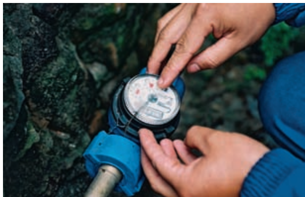
FIGURA 35 – VERIFICAÇÃO DE HIDRÔMETRO.
