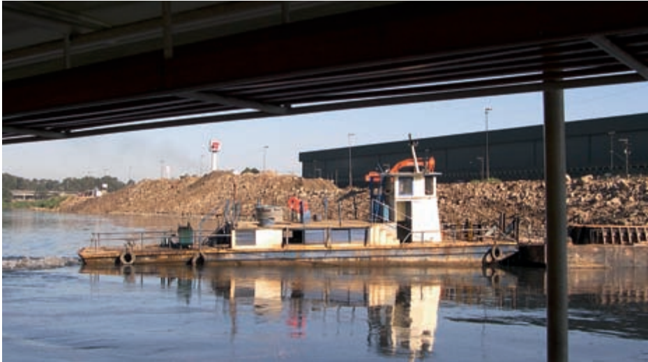
FIGURA 26 – OBRAS NO RIO TIETÊ.
