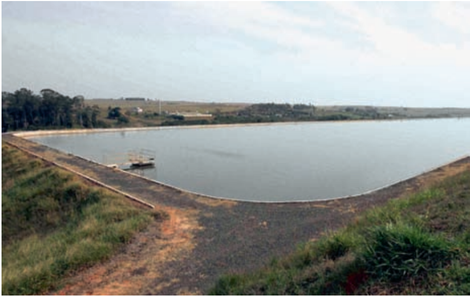
FIGURA 23 – TRATAMENTO DE ÁGUA PARA REUSO.
