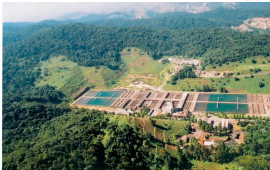
FIGURA 24 – ESTAÇÃO DE TRATAMENTO DE ESGOTO - CANTAREIRA, SP.
