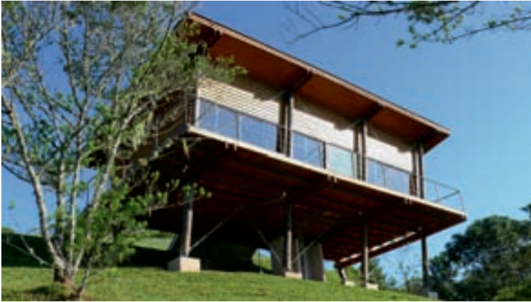
FIGURA 31 – FACHADA COM VIDROS AMPLOS, IDEAL PARA ILUMINAÇÃO NATURAL. FONTE: ANDRÉ EISENLOHR
