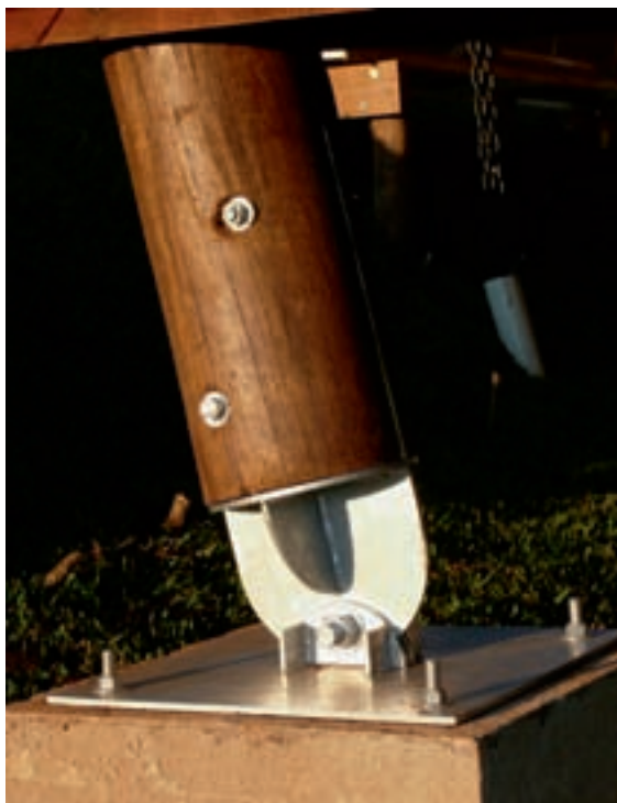
FIGURA 33 – PILARES DE SUSTENTAÇÃO COM MADEIRAS DE REFLORESTAMENTO. FONTE: ANDRÉ EISENLOHR
