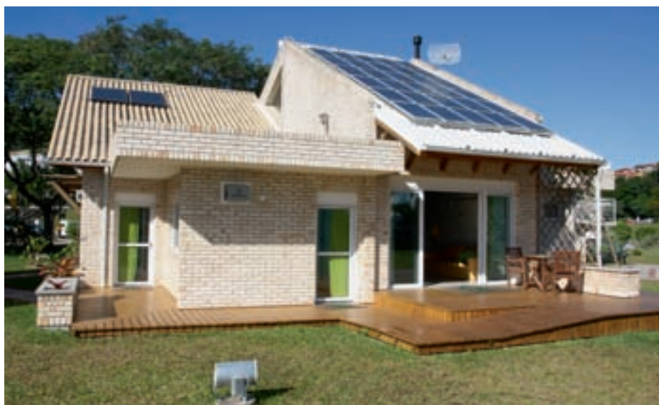
FIGURA 9 – (A) PLACAS FOTOVOLTAICAS. (B) PLACAS FOTOVOLTAICAS INSTALADAS NA “CASA EFICIENTE”, PROJETO EM PARCERIA COM A UFSC/LABEEE E A ELETROBRÁS (AUTORIA: ANÍSIO ELIAS BORGES).
