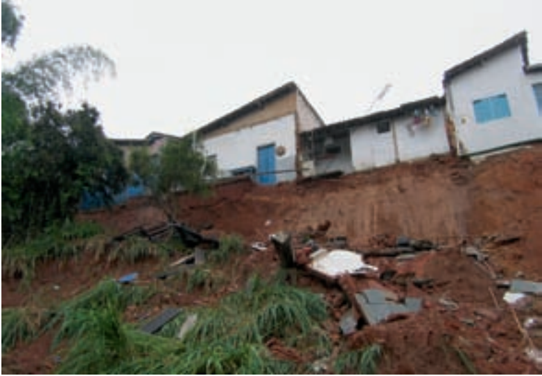
FIGURA 2 – OCUPAÇÃO EM ÁREA DE RISCO.
