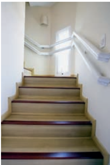
FIGURA 28 – ESCADAS COM CORRIMÃO E SENSORES DE PRESENÇA PARA ILUMINAÇÃO. FONTE: MARCONDES PERITO ENGENHARIA E ARQUITETURA
