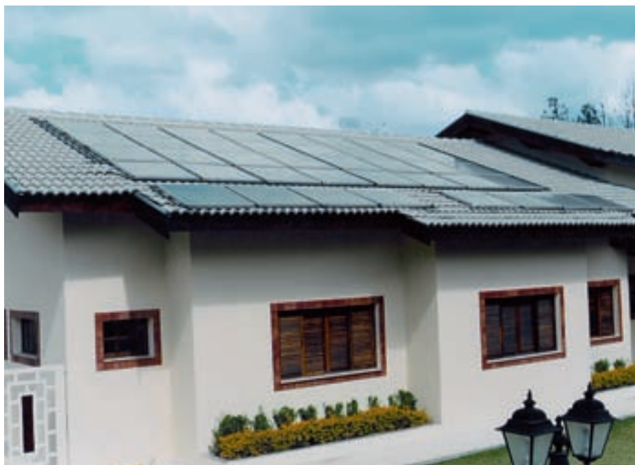
FIGURA 7 – RESIDÊNCIA COM COLETORES SOLARES PARA AQUECIMENTO DA ÁGUA. (FONTE: HELIOTEK, 2010)
