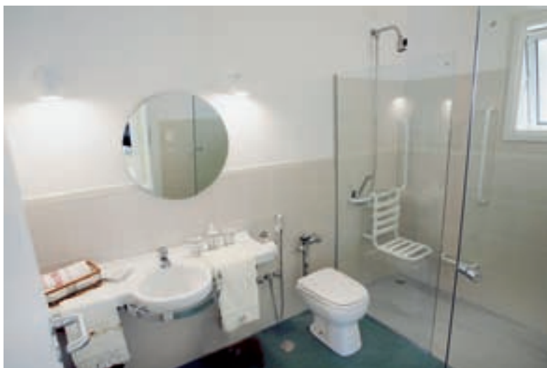
FIGURA 30 – BANHEIRO COM BARRAS E CADEIRA DE APOIO. FONTE: MARCONDES PERITO ENGENHARIA E ARQUITETURA
