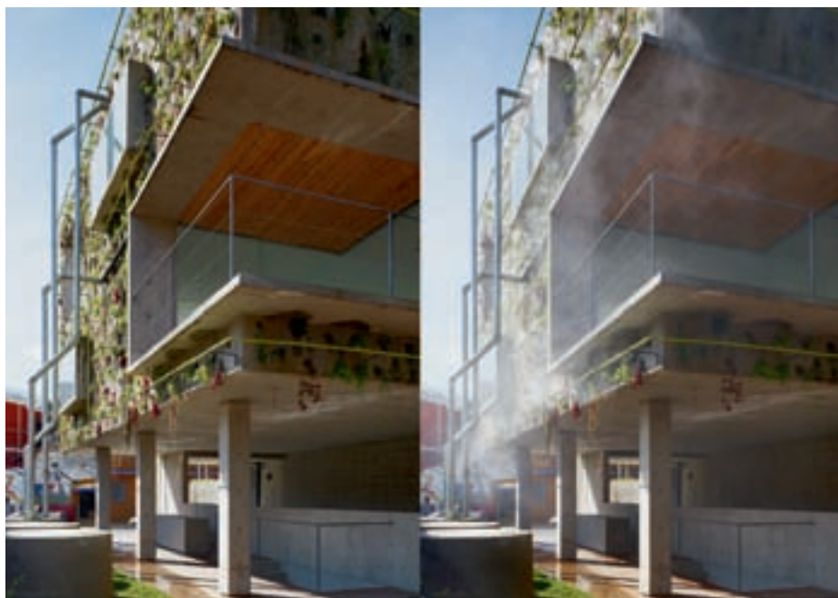
FIGURA 37 – FACHADAS COM VEGETAÇÃO LOCAL E IRRIGAÇÃO POR TUBULAÇÕES QUE RODEIAM A EDIFICAÇÃO GARANTEM O CONFORTO TÉRMICO DOS SEUS OCUPANTES. (FONTE: TRIPTYQUE ARQUITETURA)
