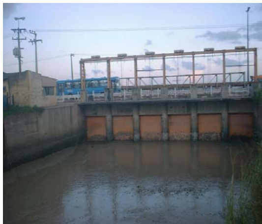
Figura 6: Barragem do Bacanga - vertedouro
