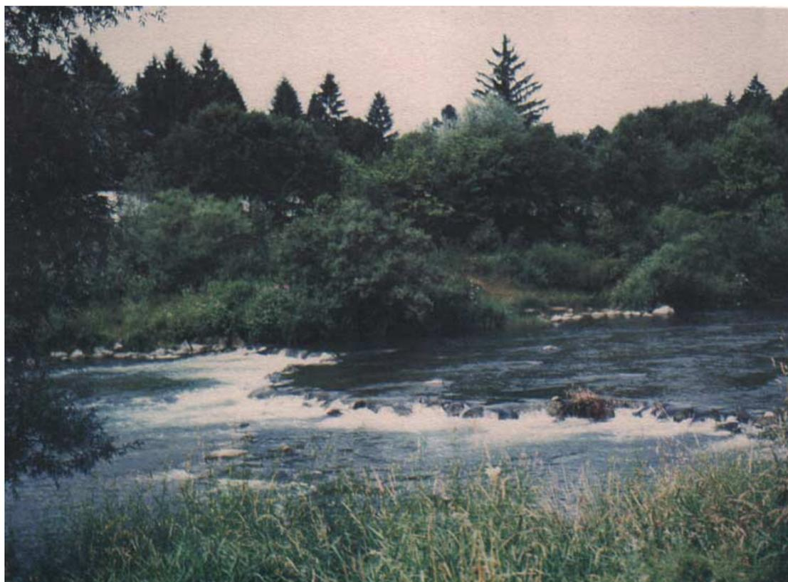
Fig. 15 Tentos transversais substituindo vertedor permite novo fluxo migratório das espécies
