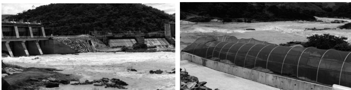
Figura 107 - Escada para peixe da UHE Ilha dos Pombos
