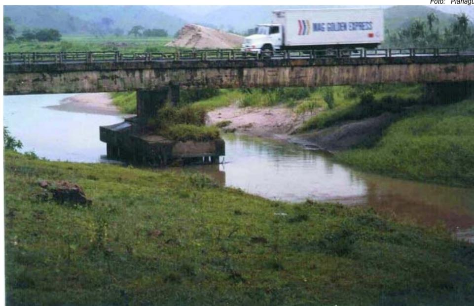
Aprofundamento do leito, em consequência o bloco no meio foi escavado com risco para a ponte
