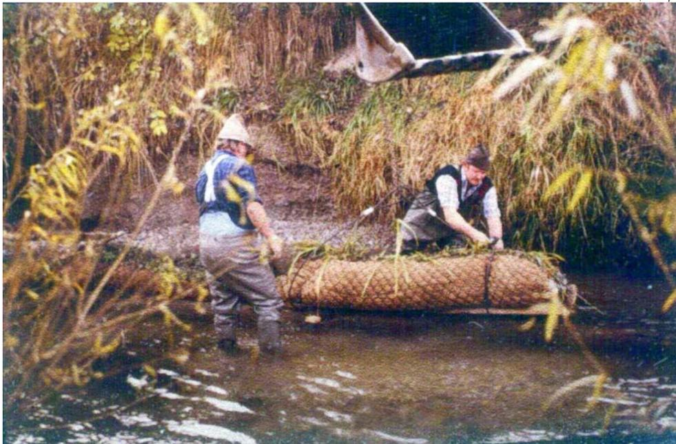
*Proteção de margem com instalação de uma faxina de tela de arame, tecido de coco, pedras, terra e plantas vivas*
