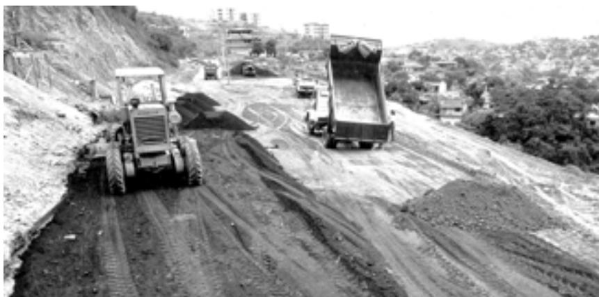
**FIGURA 8 - EXECUÇÃO DE ATERRO E PAVIMENTAÇÃO COM RECICLADOS (B. HORIZONTE / MG)**
