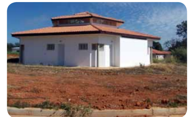
Obras do Centro de Conservação da Fauna Silvestre do Estado de São Paulo - CECFAU, localizado na Divisão de Produção Rural, da Fundação Parque Zoológico.
